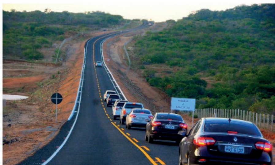
Figura 2 – Trecho rodoviário do estado da Paraíba
