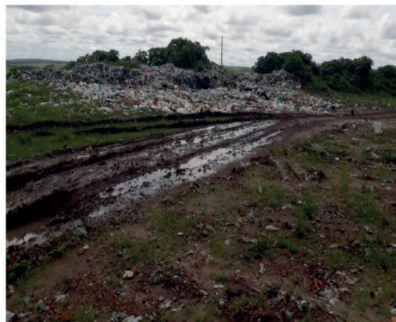
Figura 5: Acesso à frente de descarga.
