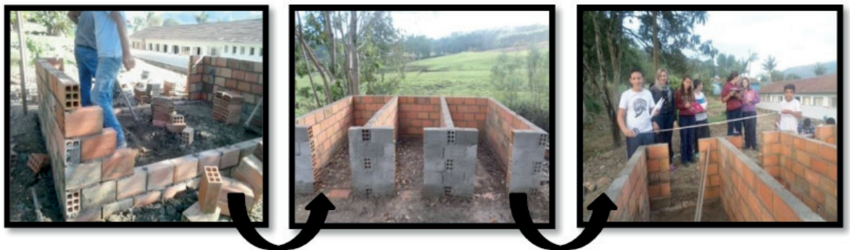
Figura 3 – Construção da composteira escolar/ conferindo as medidas Fonte: Estudantes do 7º ano (2016)
