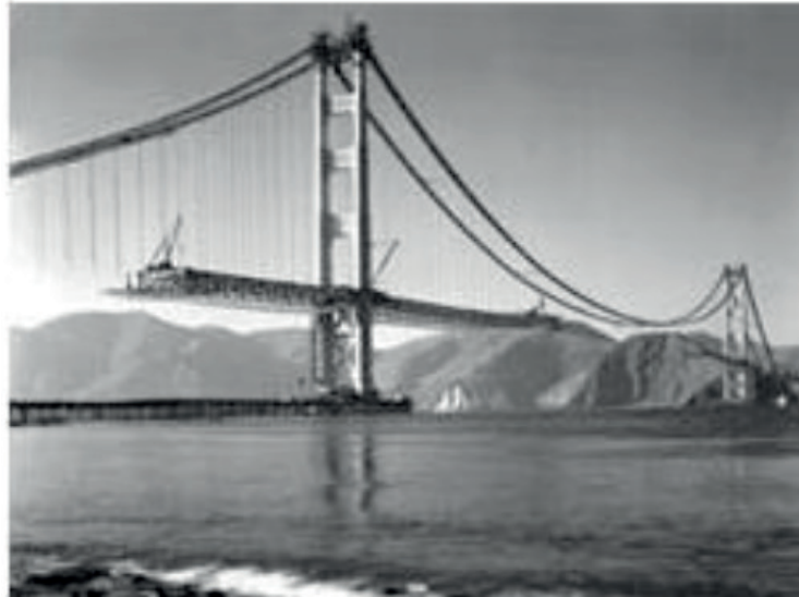
Figura 17. Construção de uma ponte com suspensão parabólica (OLIVEIRA; VARANDAS, 1999).
