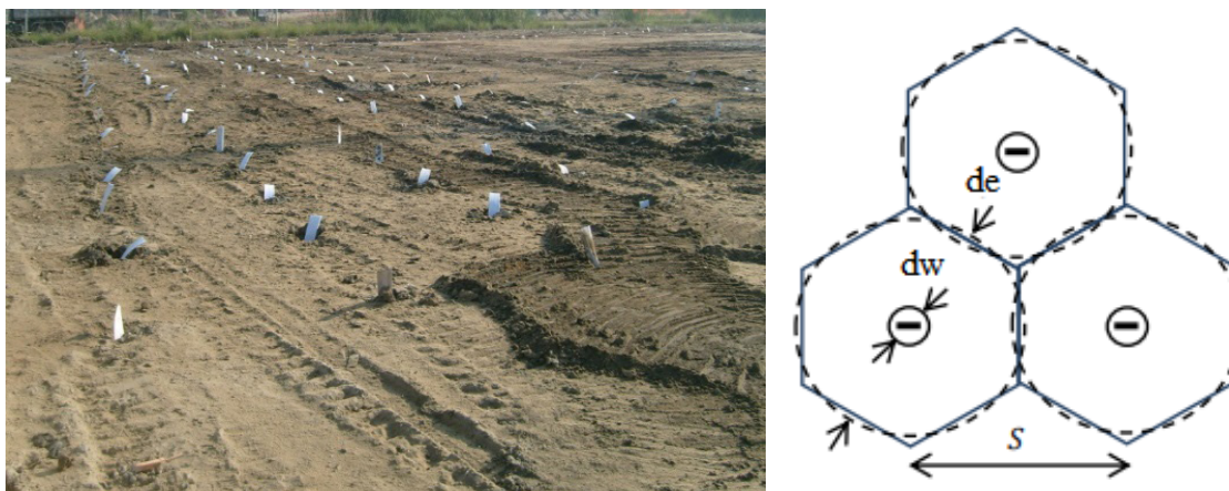
Figura 2: (a) Vista geral da área de estudo, (b) Detalhe da malha de cravação e especificação para dimensionamento.
