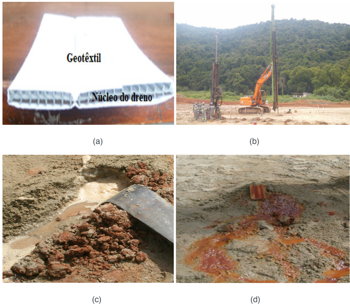
Figura 3. (a) Detalhe geodreno dimensões 5 x 100 mm, (b) Vista geral do maquinário para cravação de geodrenos, (c) Fluxo de água após execução dos geodrenos verticais, (d) Fluxo de água após 72 horas execução dos geodrenos verticais.
