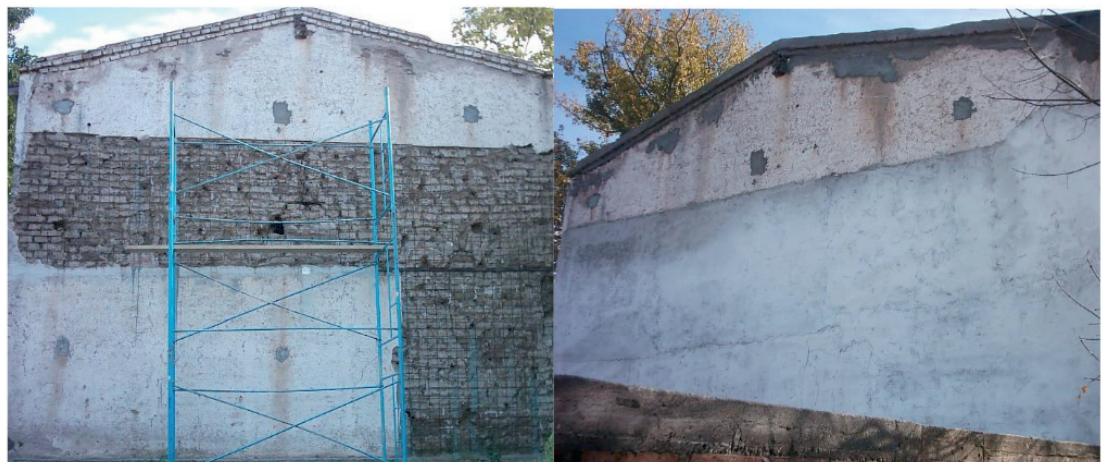
Fig. 7: Fachada Sur: Izq. Refuerzos de malla y conectores. Der. Revoque grueso cementicio. (Fuente: Genovese F; 2006)
