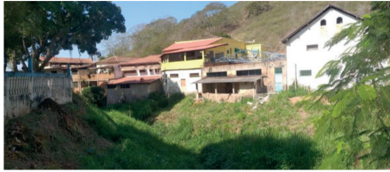
Figura 2 – Trecho de APP do Rio Muqui do Norte com ausência de árvores e construções muito próximas
