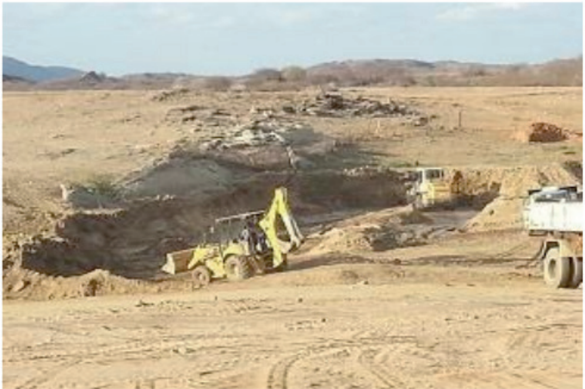
FOTO 02: Retroescavadeira e máquina pá enchedeira retirando sedimentos do leito do açude.
