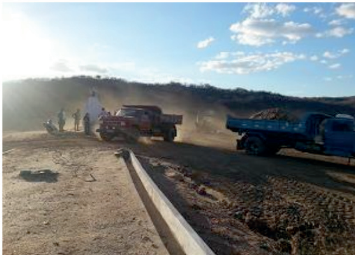
FOTO 03: Caminhões caçambas transportando material e depositando na parede oposta ao açude, fortalecendo a mesma para um possível aumento de sua capacidade.
