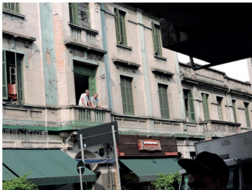
Figura 03: Edifício antigo residencial com comércio no térreo – Av. São João.
