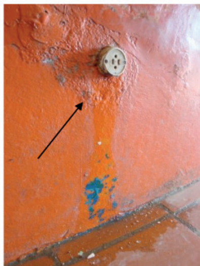
Figura 11 – Indícios de vazamentos por fissura ou ruptura de tubulações embutidas
