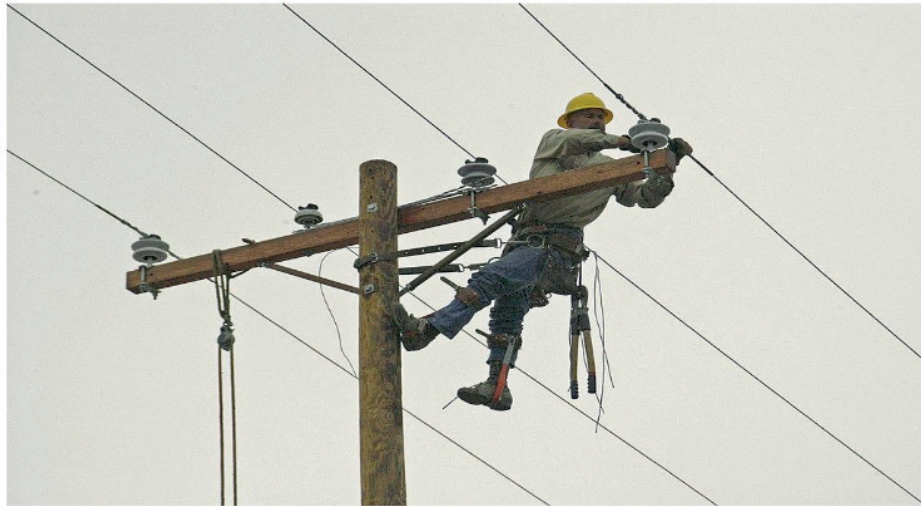
Figura 2 – Trabalhador eletricitista reparando uma linha danificada
