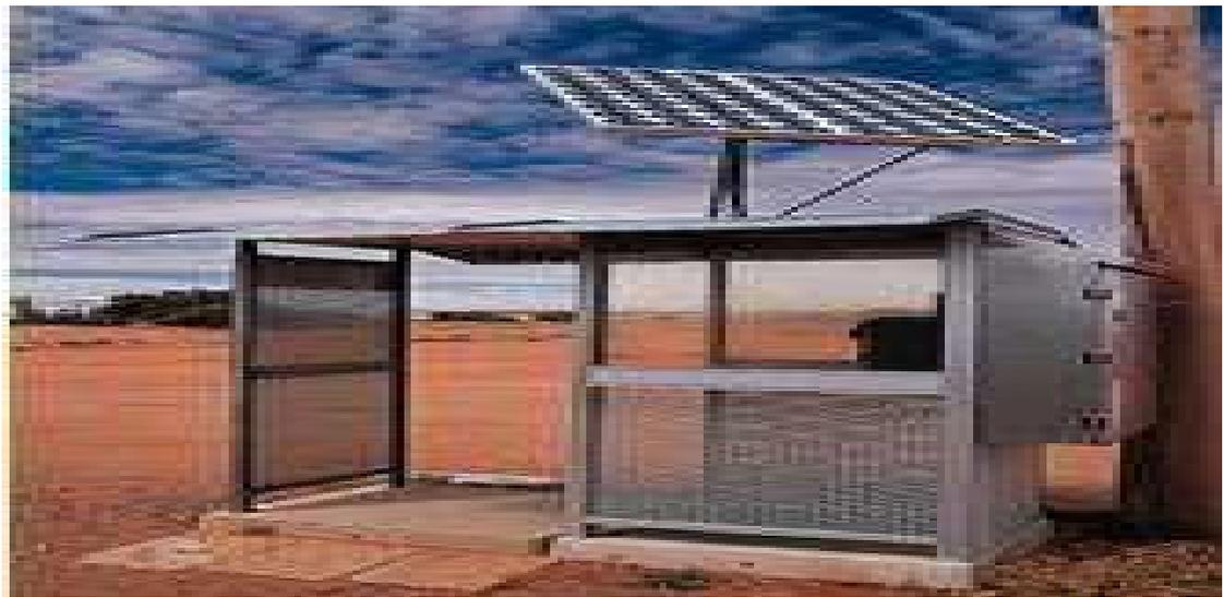
Figura 1 - Painel solar fotovoltaico que usa energia da luz solar para sustentar telefone celular público em local isolado na Austrália
