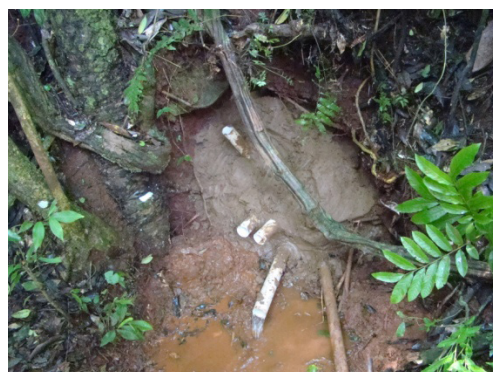
Figura 10: nascente propriedade 4 após a aplicação da técnica solo-cimento Fonte: Os autores, 2015.
