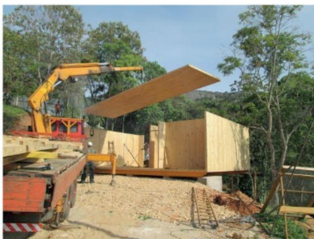
Figura 4: Aplicação de CLT
