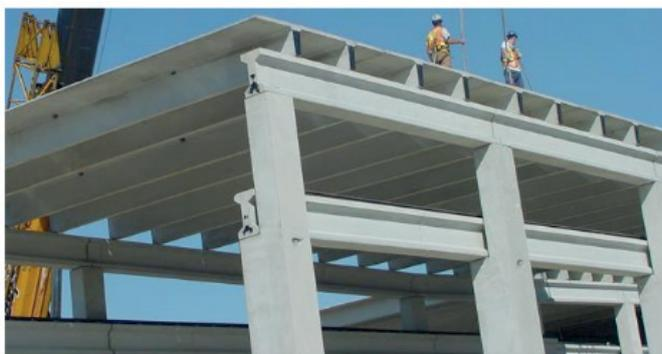
Figura 5: Aplicação de concreto
