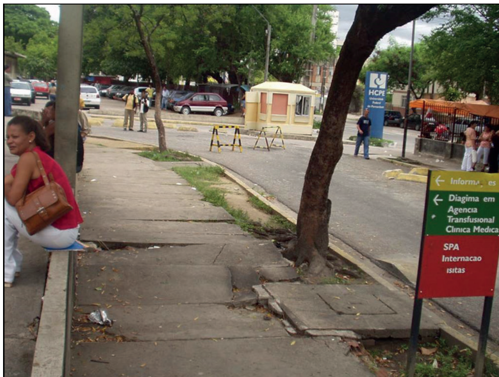
Foto 23: Calçadas internas do entorno urbano do HC. Aplicação dos conceitos de calçadas acessíveis, apesar do desgaste e ausência de manutenção.
