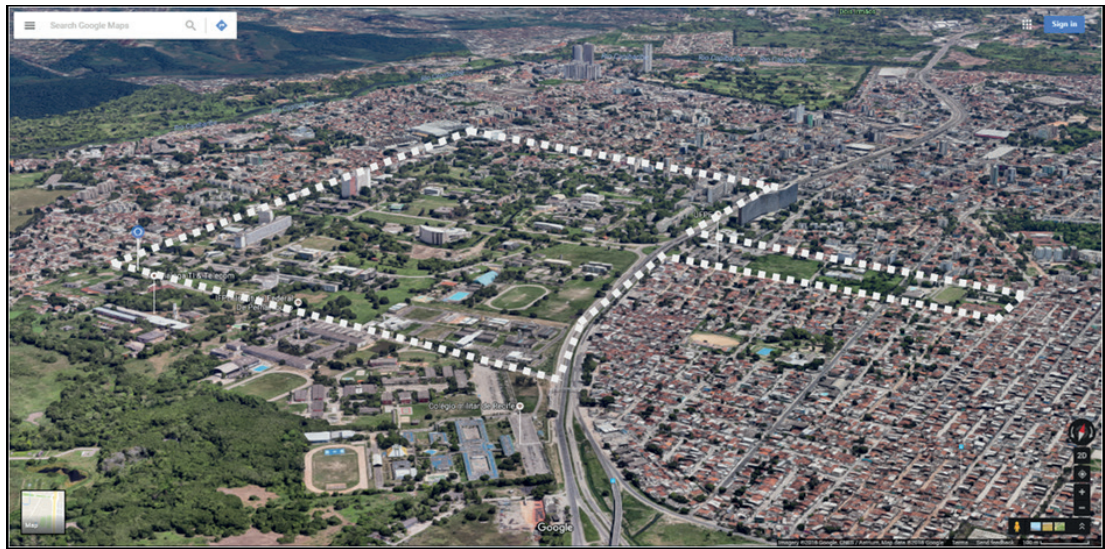
Foto 26: Vista panorâmica do Campus Joaquim Amazonas/UFPE e arredores, Recife/PE.
