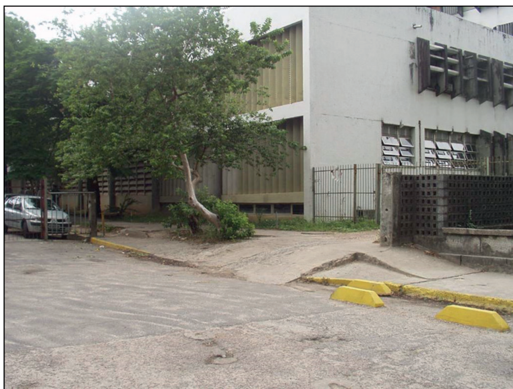
Foto 29: Interrupção da passagem entre estacionamentos do CCS e HC.
