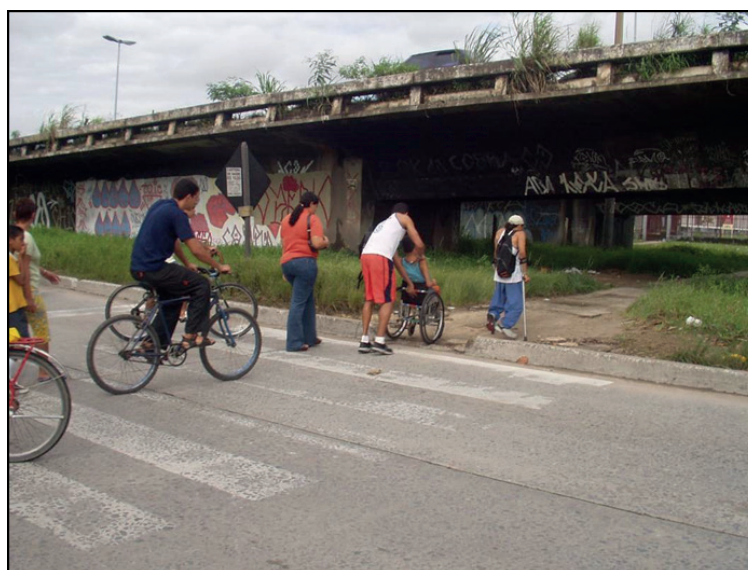
Foto 18: Faixa de pedestres na via local da Rodovia BR-101 em 2004. Ausência de rampa e calçamento após travessia.
