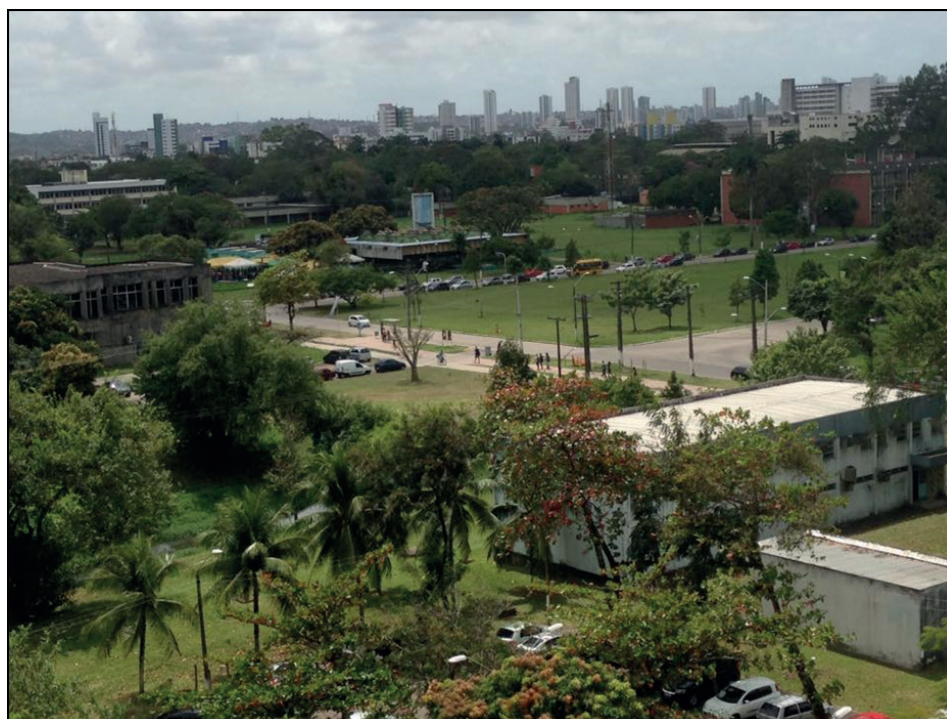
Foto 38: Vista das Avenidas dos Reitores e Reitor Joaquim Amazonas. Construção de calçadas acessíveis e cicloviás. UFPE, Campus Joaquim Amazonas, Recife, Brasil.
