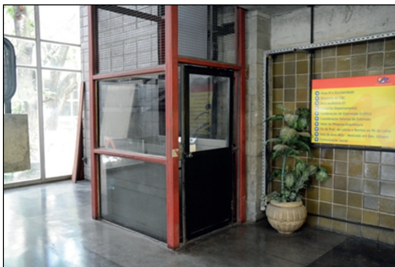
Foto 17: Modernização da plataforma de elevação vertical do CAC.
