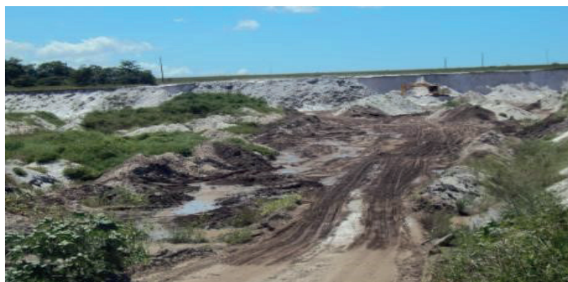
Figura 4: Aspectos da área do Assentamento Engenho Ubú, com extração de areia (Goiana, PE).
