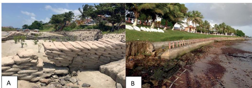
Figura 6 – A) Sacos de areia e concreto para conter a erosão costeira no município de Salinópolis-PA; B) muro de contenção parcialmente destruído na orla de Soure-PA (Fotos: Milena Andrade)
