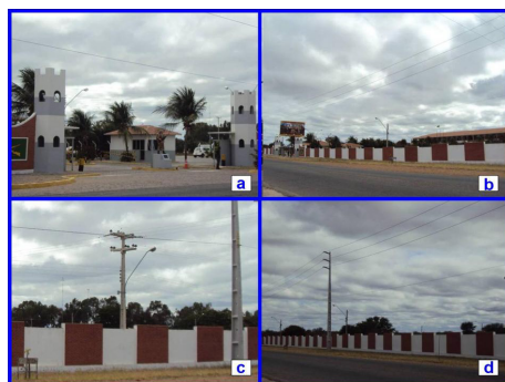
Figura 7. 72º Batalhão de Infantaria Motorizado: a) entrada principal; b) área frontal da entrada; c) vista frontal, com destaque para vegetação; e d) Vista lateral.
