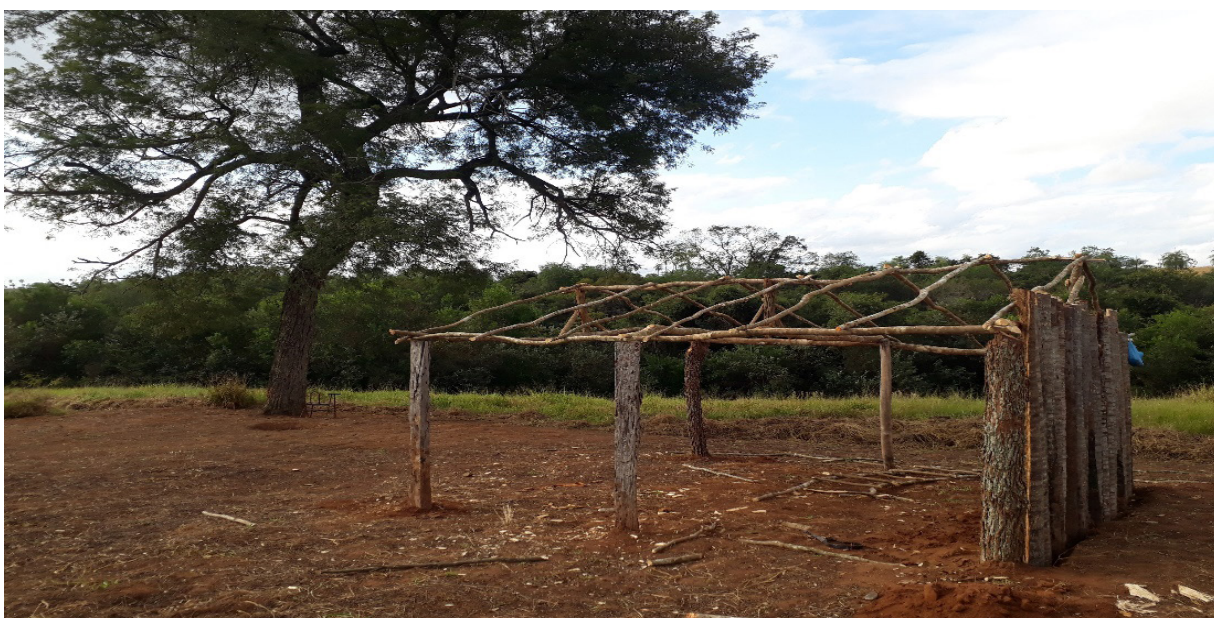
Casa que está sendo construída por Esgaibe
