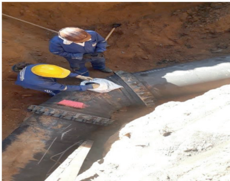
Figura 07: Junta Travada Externa
