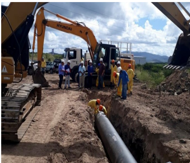
Figura 04: Instalação da Junta Travada Externa
