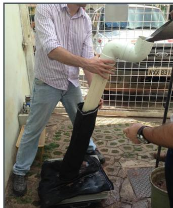
Figura 11. Preenchimento do Tubo de Geotêxtil.
