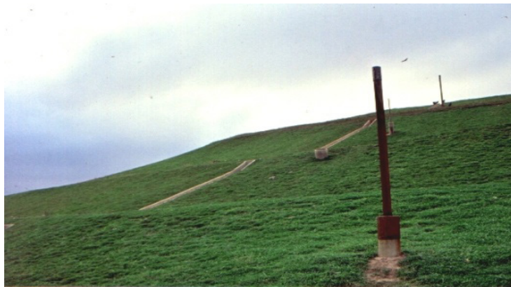
Figura 3 – Drenagem de chorume e de biogás de Curitiba, PR.
