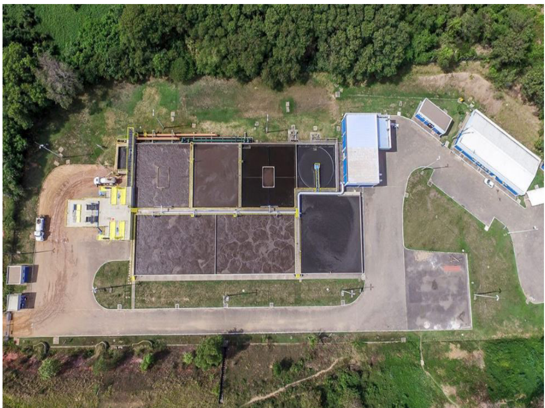
Figura 1. Vista aérea ETE Bandeirantes.
