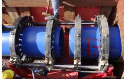
Figura 3: Execução Solda de Termofusão
