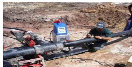
Figura 8: Máquina de Solda de Eletrofusão
