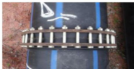
Figura 10: União com Colarinho + Flange
