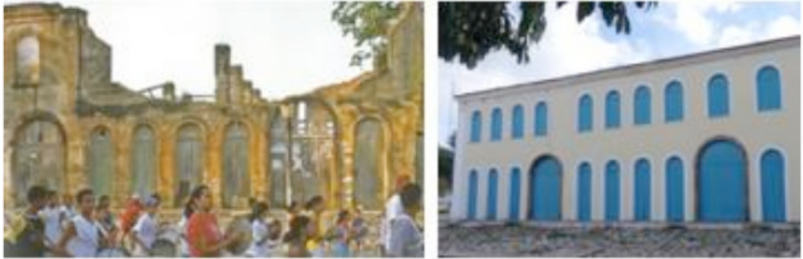
Figura 3: (esquerda) - Ruínas do Trapiche Santo Antônio, antes do projeto Monumenta em 2006. Fonte: Bonduki, 2010, p. 233. (direita) – Trapiche Santo Antônio (re)inventado; recuperação das alvenarias recentemente, sempre novo. Não se pode tratar o antigo da mesma maneira que se trata o novo. Mesmo aparentando perfeito estado de conservação, as paredes antigas já começam a apresentar degradações por umidade, enquanto as paredes novas, feitas como complemento, dificilmente apresentam este tipo de degradação. Foto: Silva, abr. 2019.
