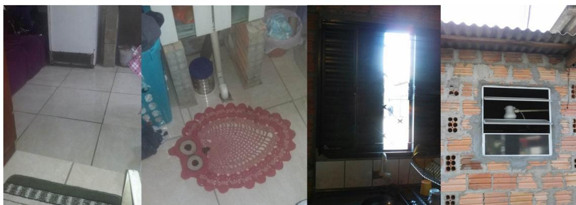
Figura 8: Piso colocado, novas esquadrias e rede hidráulica instalada. Fonte: ASCPOA.
