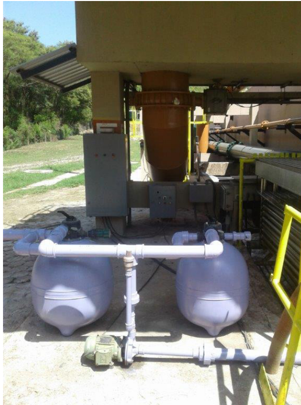
Figura 2. Sistema de polimento de efluente da ETE Bandeirantes.
