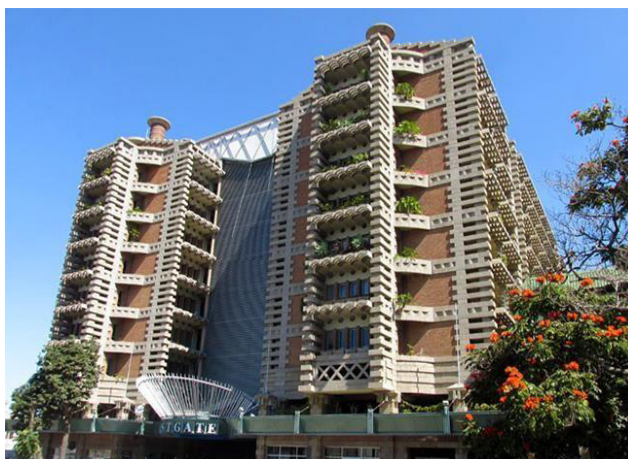
Figura 10: Fachada do Eastgate Building. Fonte: http://www.condominiosverdes.com.br/voce-ja-ouviu-falar-em-biomimetica/
