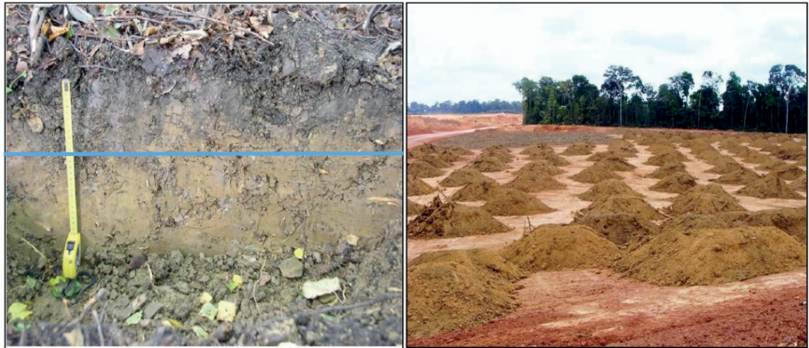
Figura 1. A) – Topsoil a ser retirado da floresta e; B) Pilhas de topsoil que serão espalhadas em áreas total.
