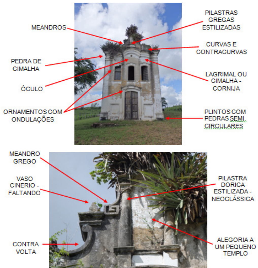
Figura 3 – (Acima) – Fachada principal da edificação com elementos ornamentais compositivos. (Abaixo) – Frontão da Capela da Fazenda Ribeira. Fonte: Eder Donizeti, jul. 2016.
