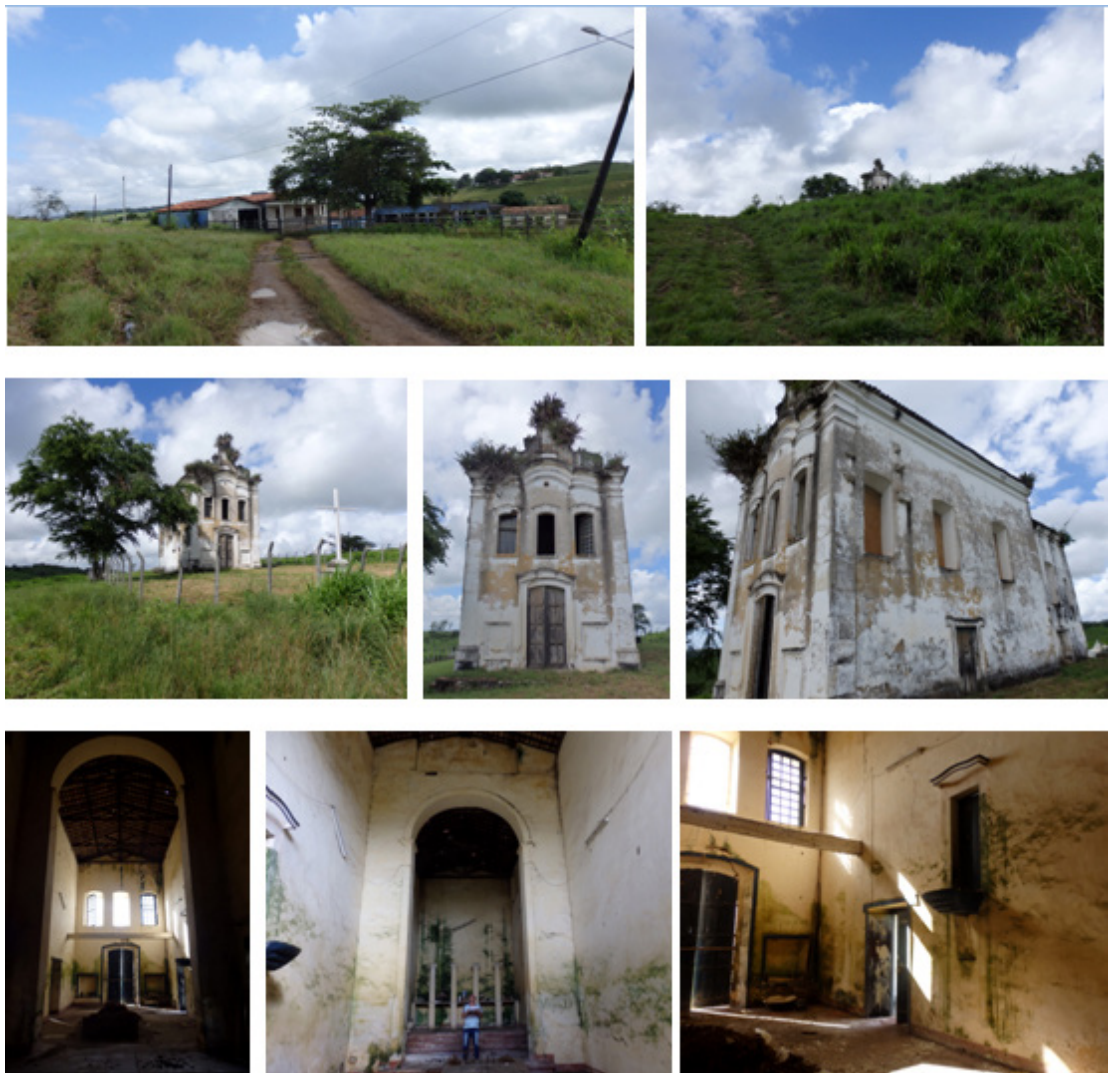
Figura 1 – (Acima) – Esquerda: Entrada da Fazenda Ribeira. Direita: Vista da Capela da BR 235. (Centro) - Esquerda: Vista frontal da Capela. Centro: Fachada principal. Direita: Fachada lateral direita. (Abaixo) – Esquerda: Interior da Capela. Centro: Capela-mor. Direita: Vista geral do interior. Fonte: Eder Donizeti, jul. 2016.
