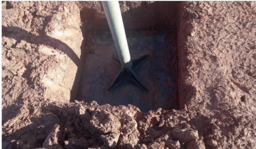
Figura 5 - Cava (remoção de solo) pronta já com a placa de recalque inserida.
