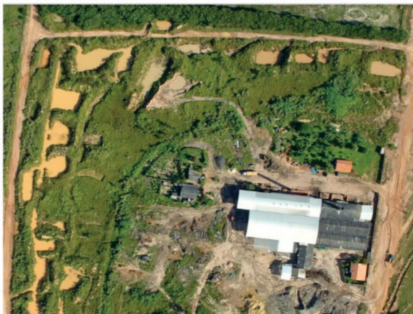
Figura 3. Caixas de contenção. Fonte: PMC – MT (2017).
