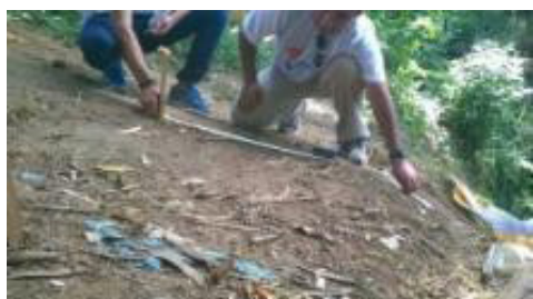
Figura 1. Estacas a 1m da encosta; Fonte: foto do autor. IFMA, 2015.
