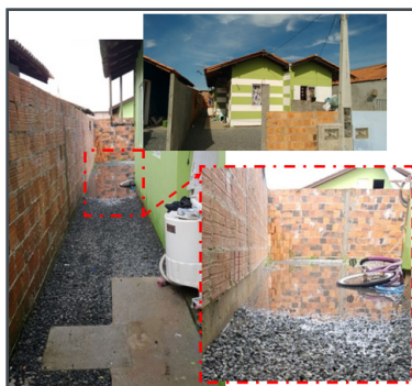
Imagem 9 – Formação da bacia de retenção (fotos do beneficiário – transferidas ao autor)
