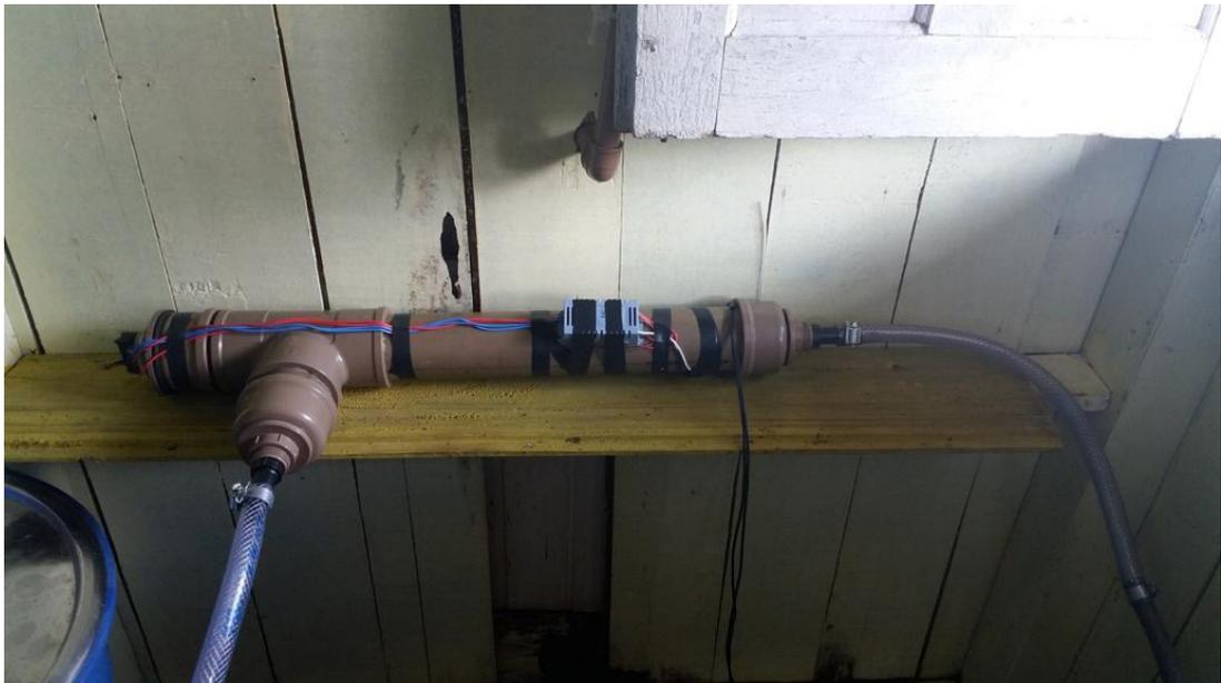
Figura 5: Filtro UV após a instalação
