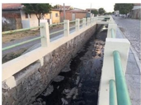
Figura 5 – Canal de Esgoto (Centro)
