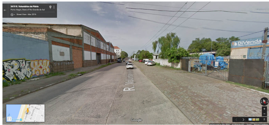
Figura 02: Fachadas sem “olhos” para a rua, na Voluntários da Pátria.
