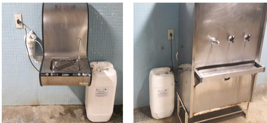
Figura 2. Recipiente acoplado aos bebedouros para coleta da água desperdiçada.
