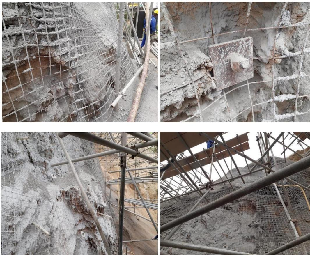
Figura 11: Pontos de concretagem com espessuras superiores a de projeto. Fonte: elaborado pelos autores.
