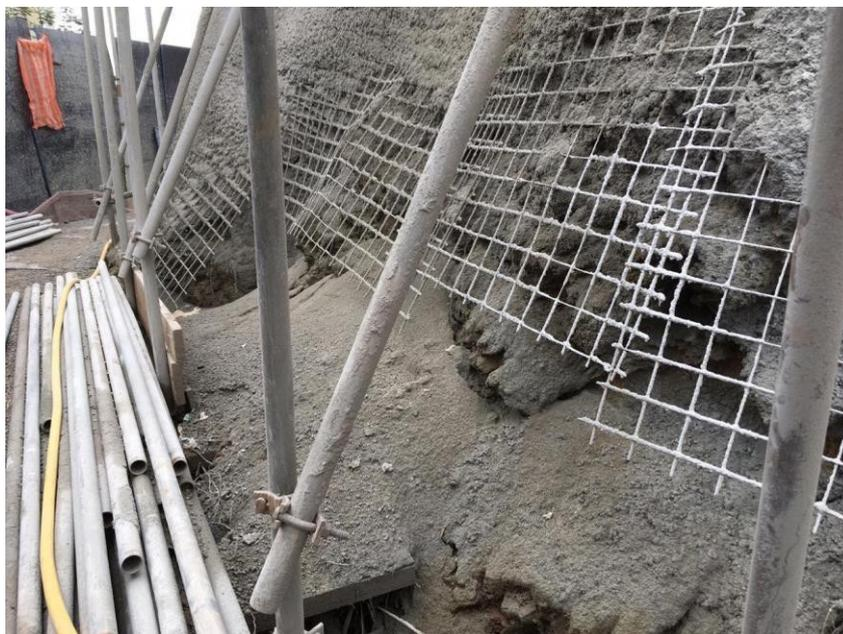
Figura 5: Desperdício de material devido à não adesão da mistura no talude.
