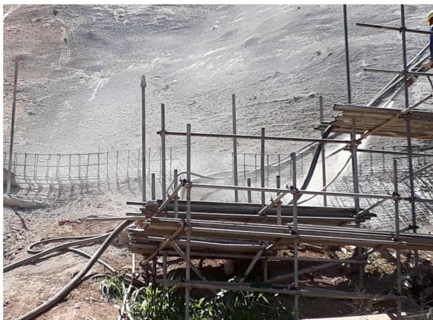
Figura 10: Reflexão ocorrendo durante a execução do projetado.
