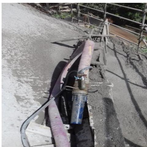
Figura 1: Bico de projeção, local onde a mistura do cimento com os agregados, mistura com a água.
