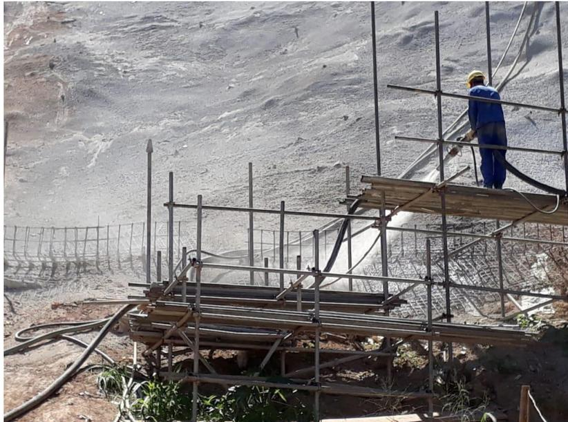
Figura 3: Concreto sendo projetado.
