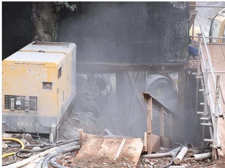
Figura 4: Levantamento de poeira devido a mistura seca.
