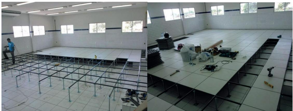
Figura 3 - Montagem do piso suspenso.
