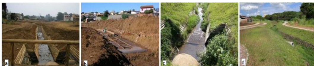
Figura 2: Obra de renaturalização do canal do Córrego Tijuco Preto, em paliçada, gabiões e geotêxteis para suportar a nova vegetação (a, b) e Córrego Tijuco Preto já renaturalizado, um ano após a obra (c, d). Fotos cedidas pelo Prof. Dr. Renato Anelli (IAU/USP).
