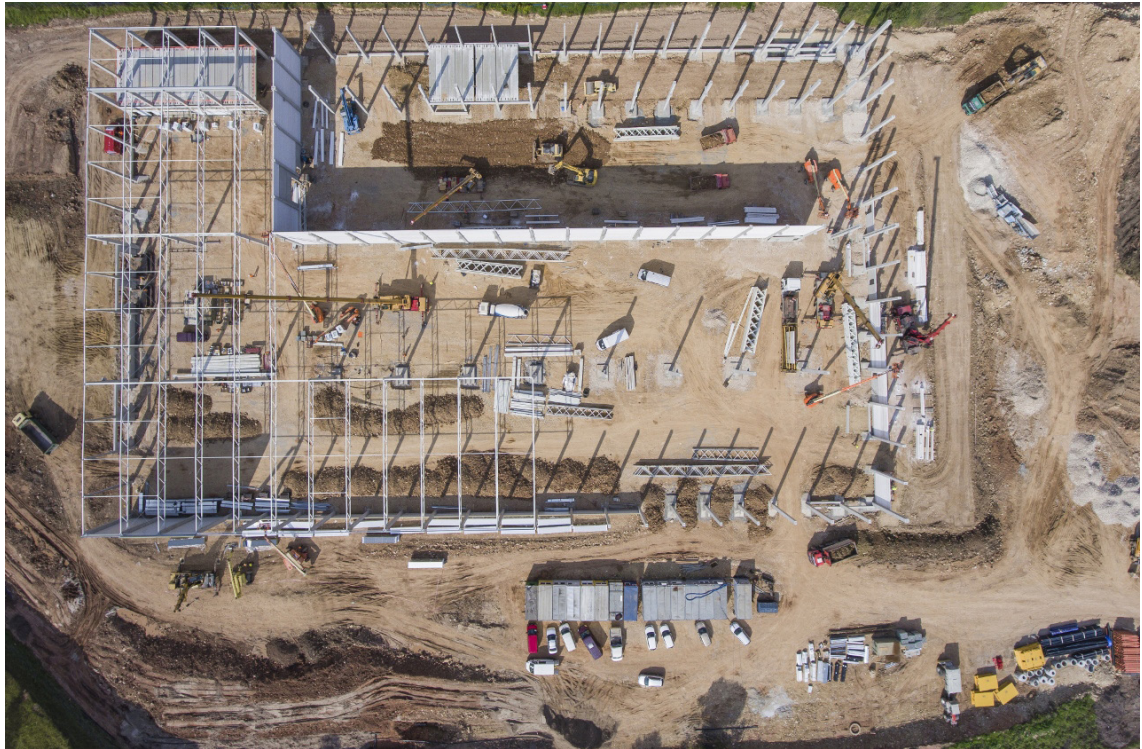
Imagem 6 – Canteiro de Obra
