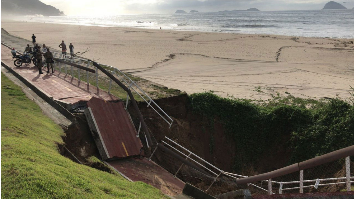
Imagem do desabamento da Ciclovia Tim Maia na Praia do Pepino – São Conrado (Disponível em: https://g1.globo.com/rj/rio-de-janeiro/noticia/ciclovia-tim-maia-desaba-novamente-no-rio.ghml )
