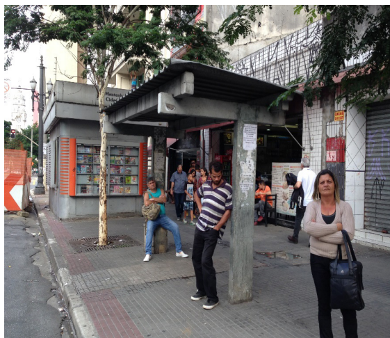
Figura 7 – Abrigo primitivo de concreto
