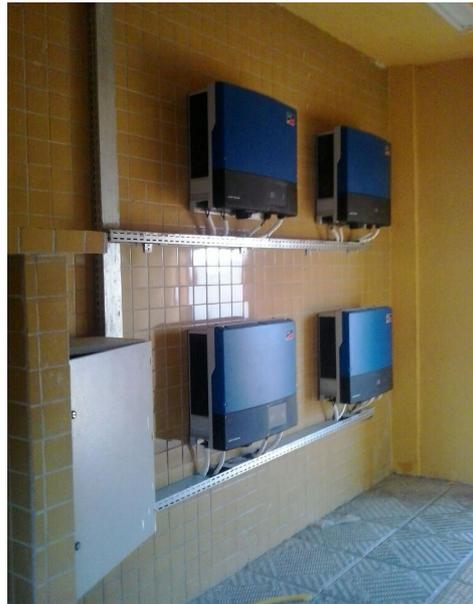
Figura 04: Inversores do sistema do IFRN campus Pau dos Ferros.
