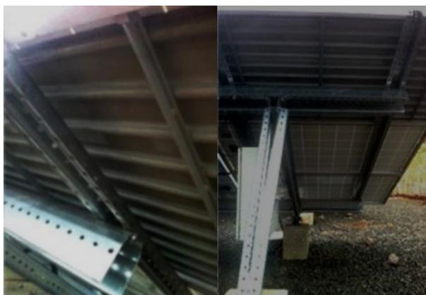
Figura 8 - Sistema arrefecedor/módulo PV instalado na UFV (SILVA et al., 2018b).
