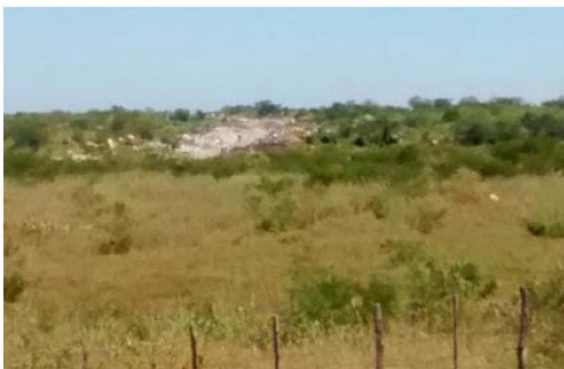
Figura 4: Vista do aterro da RN – 117
