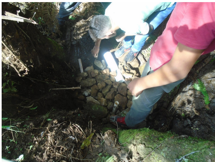
Figura 2: Processo de montagem para a evasão da água. Dia 31 de Março de 2018.
