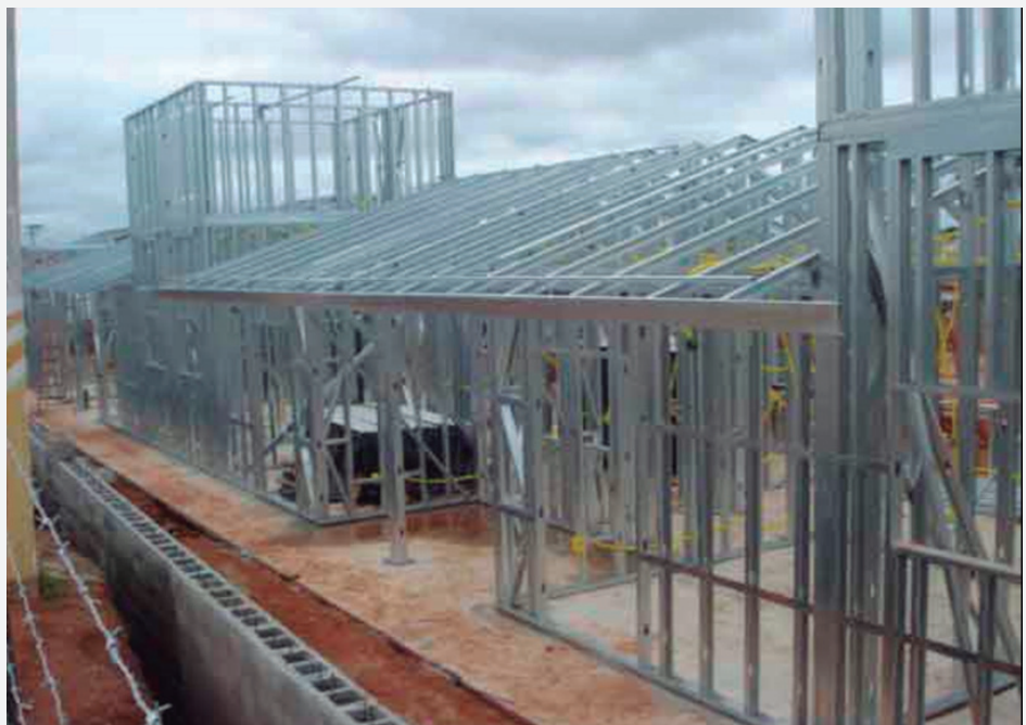
Figura 03 - Steel Frame em construção de residências populares – CDHU (Companhia de Desenvolvimento Habitacional e Urbano) em Avaré-SP.
