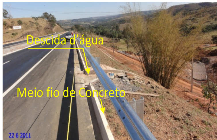
Figura 23. Trecho recuperado e finalizado (Lino, 2016).
