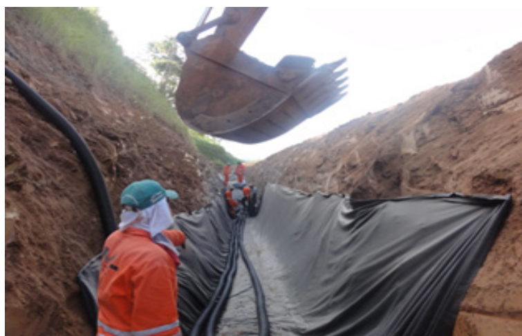
Figura 13. Execução de drenos profundos (Lino, 2011).
