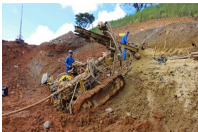
Figura 14. Perfuração para instalação de DHP (Lino, 2011).
