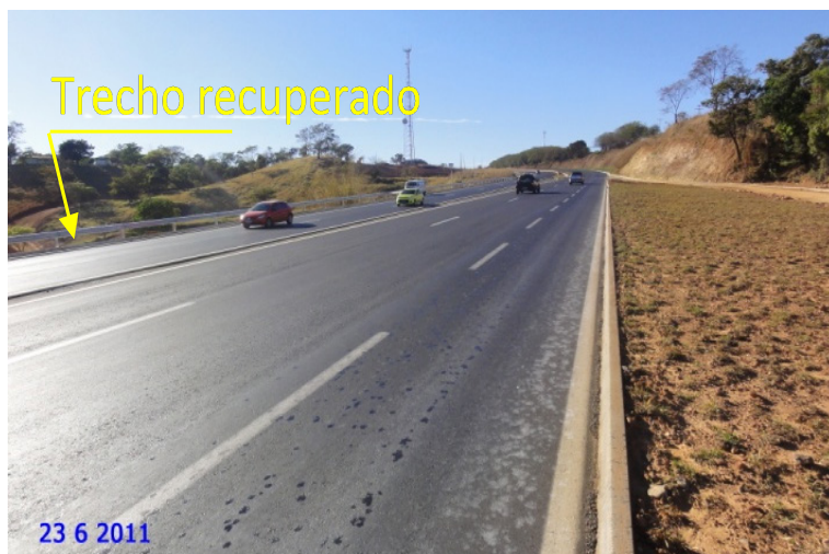
Figura 22. Trecho recuperado e finalizado (Lino, 2016).
