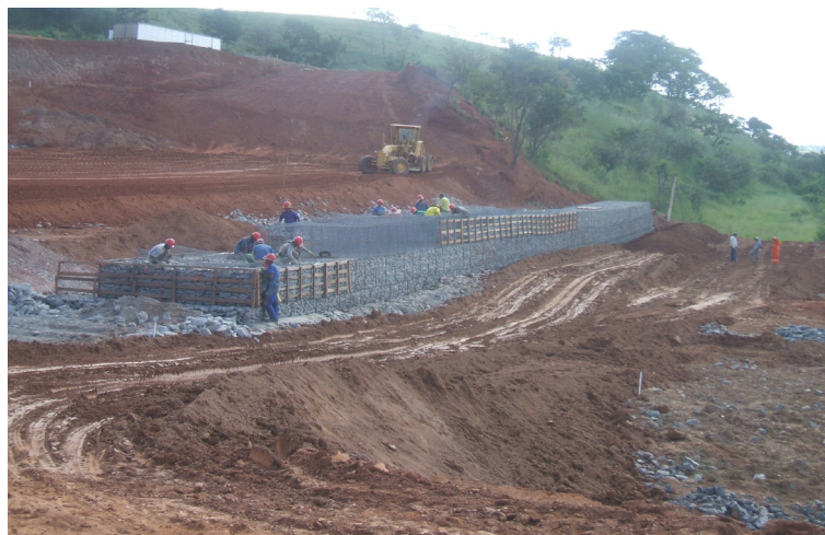
Figura 19. Execução da contenção em gabião.
