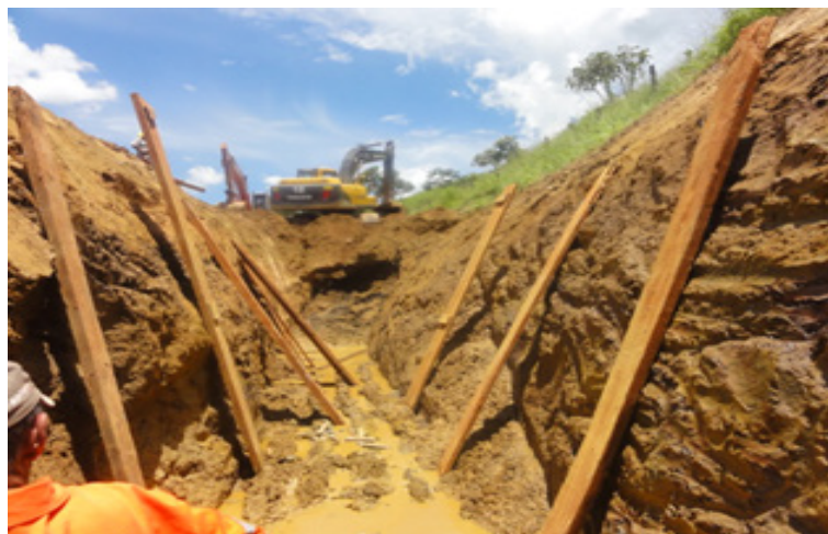
Figura 12. Escavações para a instalação de drenos profundos (Lino, 2011).
