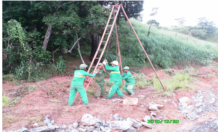
Figura 9. Vista de execução da sondagem SPT 1 (BR- 060, km 24).
